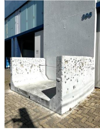
Parede para ancoragens
