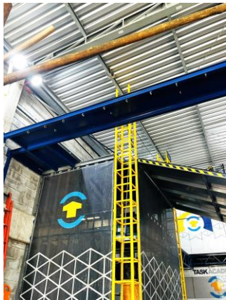
Escada fixa e passarelas
